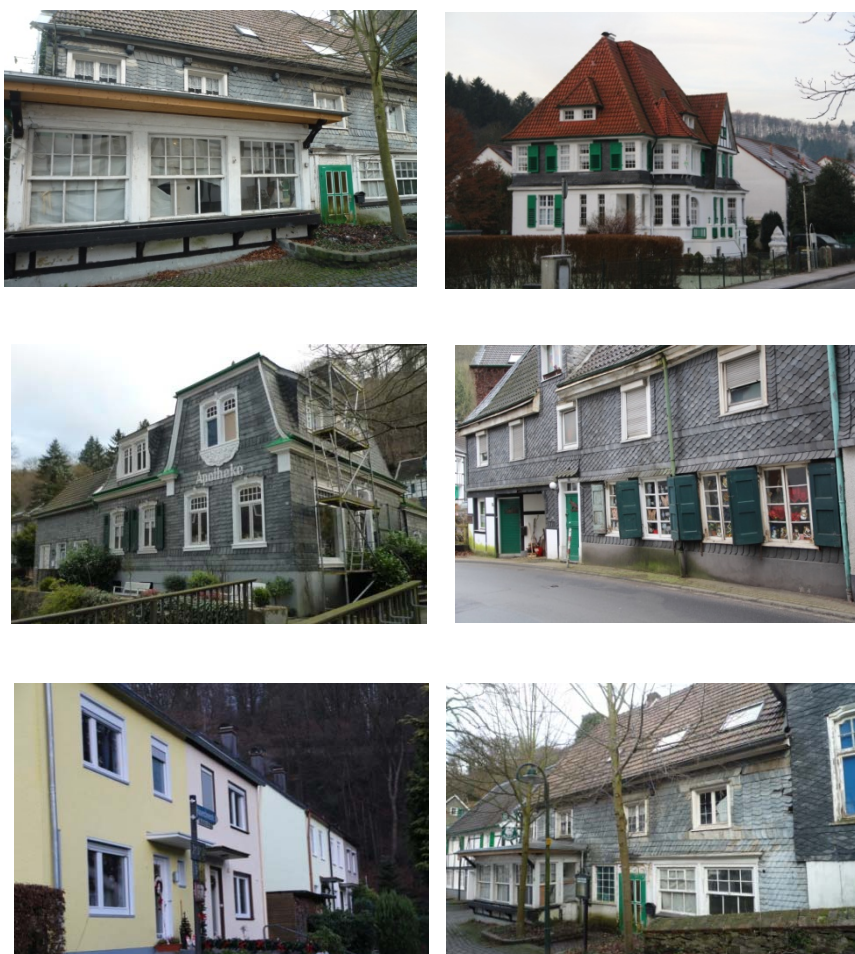
Abbildung 11 Unterschiedlicher Bauzustand der Gebäude in Solingen Burg
