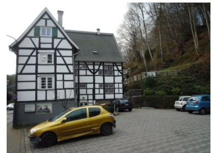
Seniorenwohnanlage Burg Residenz
